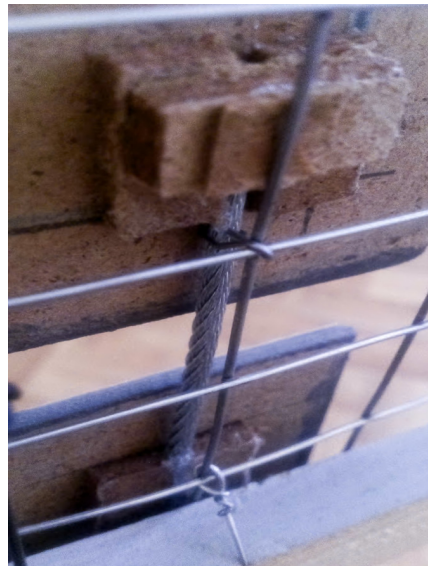
Іл. 5. Монтаж етикетажу і нижнього кута панелі за з'єднувальний елемент. Вирівнювання площини основ відносно площини сітки способом нашарування та стоншення універсальних кріпильних модулів. Вигляд ззаду стенда.
